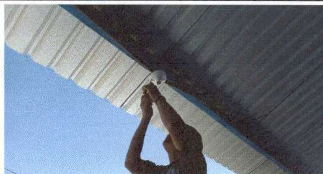
Foto 8: Sustitución de plafoneras en módulo de aulas.
