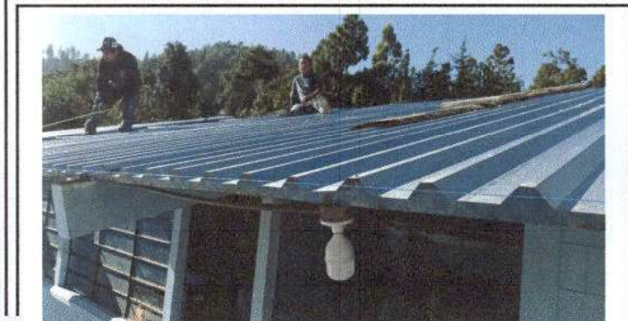
Foto 1: Sustitución de lámina, por lámina troquelada aluzinc calibre 26 en módulo de aulas.
