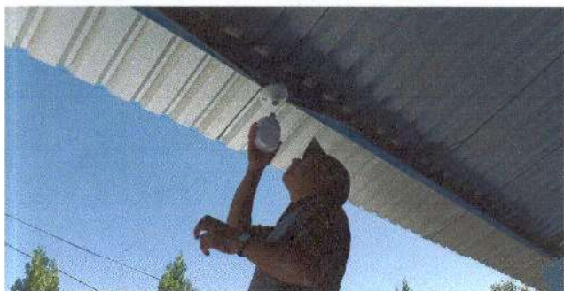
Foto 7: Sustitución de focos ahorradores en módulo de aulas.
