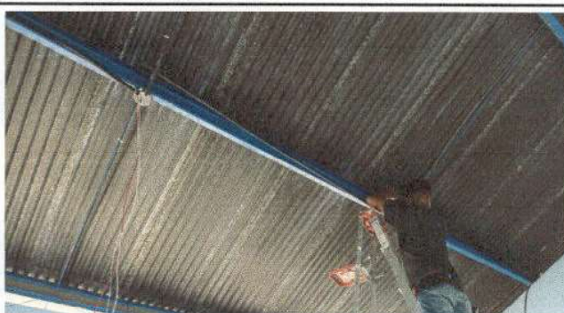
Foto 10: Sustitución de ducto eléctrico + accesorios en módulo de aulas.
