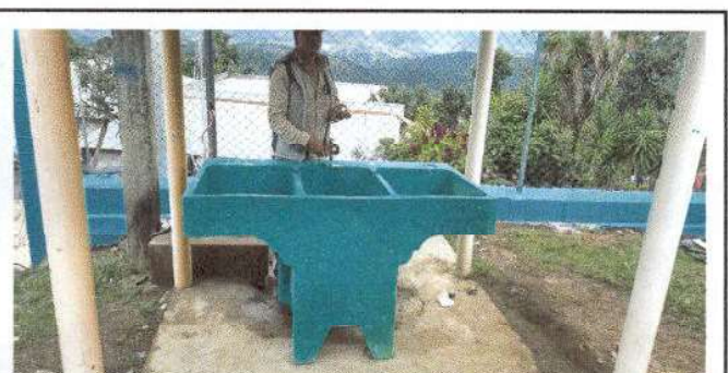
Foto 6: Sustitución de llave de chorro.
