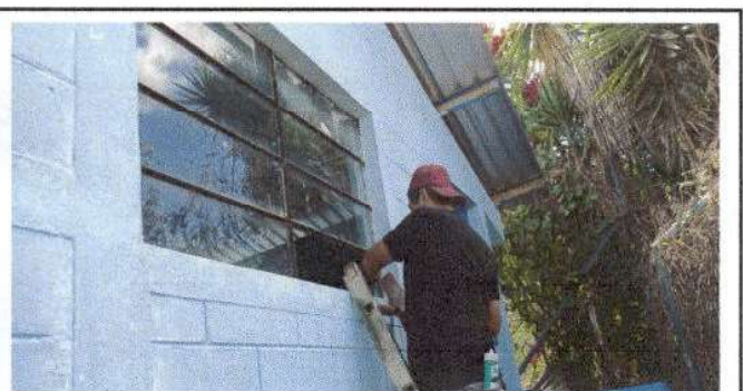
Foto 4: Sustitución de vidrio en módulo de bodega.
