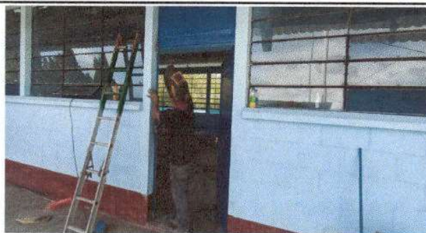
Foto 12: Fabricación e instalación de puertas de metal en módulo de aulas.
