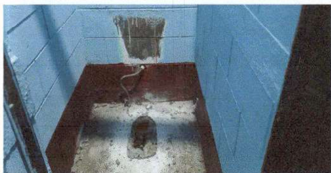
Foto 13: Instalación de inodoro en módulo de baños.
