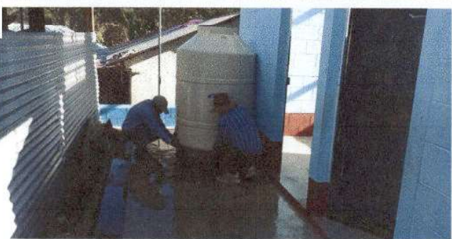
Foto 11: Sustitución de depósito de agua 1100 lt.
