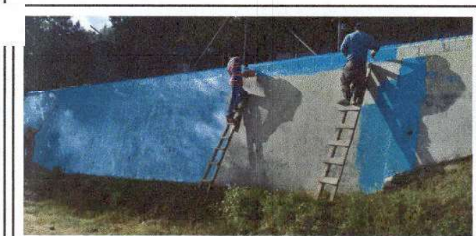
Foto 5: Pintura en muros exteriores.
