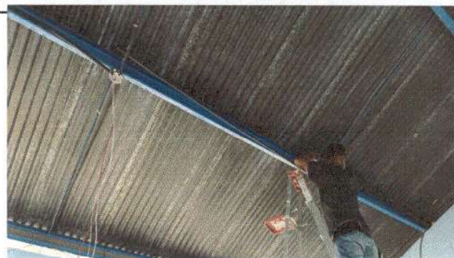
Foto 9: Sustitución de cableado eléctrico sólido en módulo de aulas.
